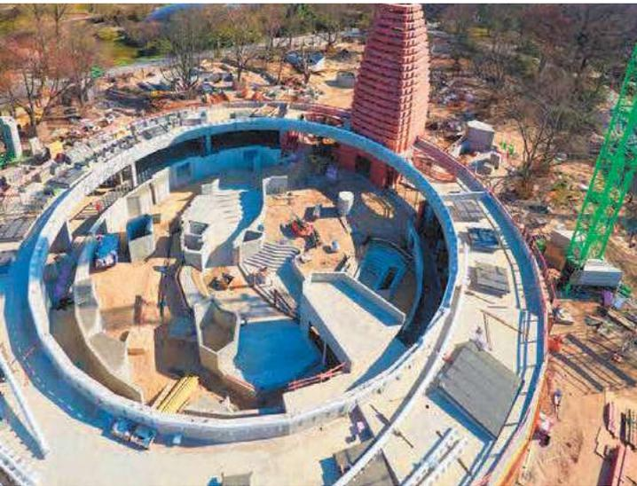
Die Berliner Nashörner erhalten ein rundes Gehege mit 52 Metern Durchmesser, in dem sogar im neuen Wasserbecken alle Stufen perfekt auf die Schrittgröße der Panzernashörner zugeschnitten wurden, wofür die Schalungskörper angepasst wurden (Bild: Zoo Berlin).
